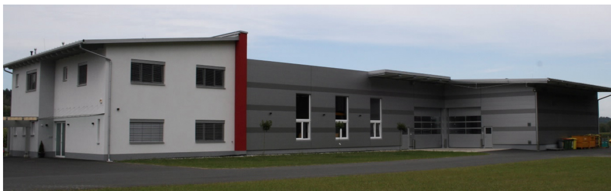
Neues Firmengelände seit Juli 2016 – siehe News Hallenbau 2016
